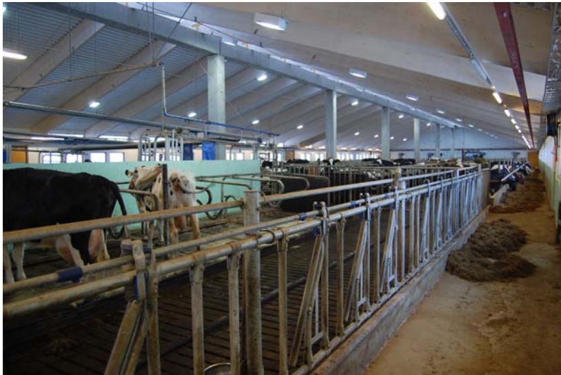
med betongsøyler med betongdrager langs midten av fjøset.
