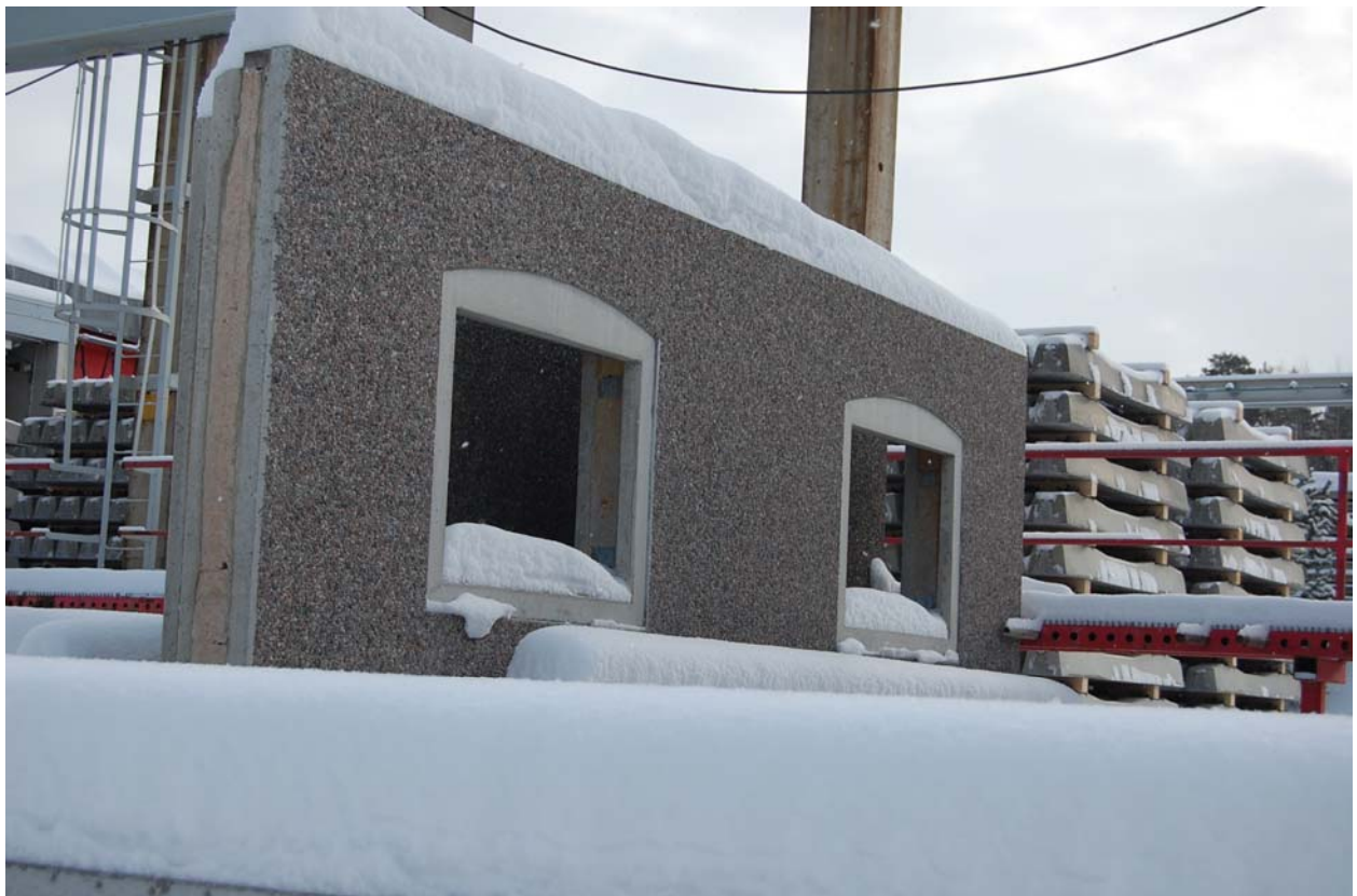
Betongelement hvor veggsknittet framgår. Ytterst og innerst 8 cm armert betong med 15 cm isolasjon mellom. Furer i isolasjonen og avløp ut nede på ytterveggen fjerner eventuell kondens. Legg også merke til mer forseggjorte vindusutforminger
